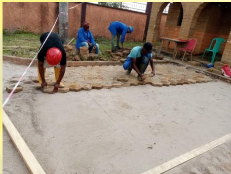
Exécution des travaux de pose de pavés
